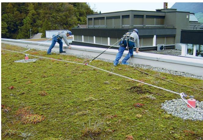
Abb. 10: Temporäres Seilsystem mit Karabinerhaken an EAP befestigt
